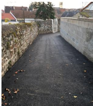
Après la construction des nouveaux logements du centre bourg, le petit chemin du Grenier à Sel nécessitait d'être remis en état. La commune a profité des travaux de voirie sur ce nouveau lotissement pour le reprofiler à l'enrobé à chaud.
