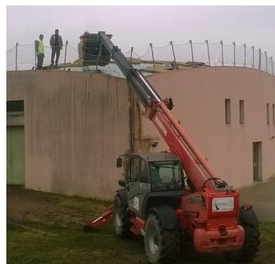
Construit en 1998, le Centre Socio Culturel a subi de nombreuses fuites d'eau, la membrane PVC du toit étant hors d'usage. Un remplacement total s'imposait, isolation comprise. Celle-ci passe de 120 mm à 170 mm; les solins et les couvertines sont également remplacés.
