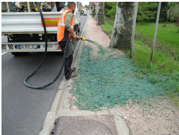
Traitement de l'Avenue Préveraud
