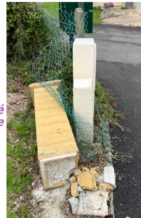
Poteau renversé à l'école
